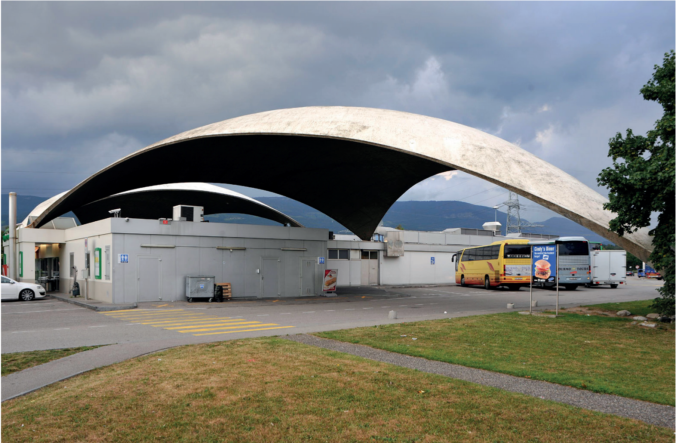
11. Area di servizio autostradale di Deitingen Sud
