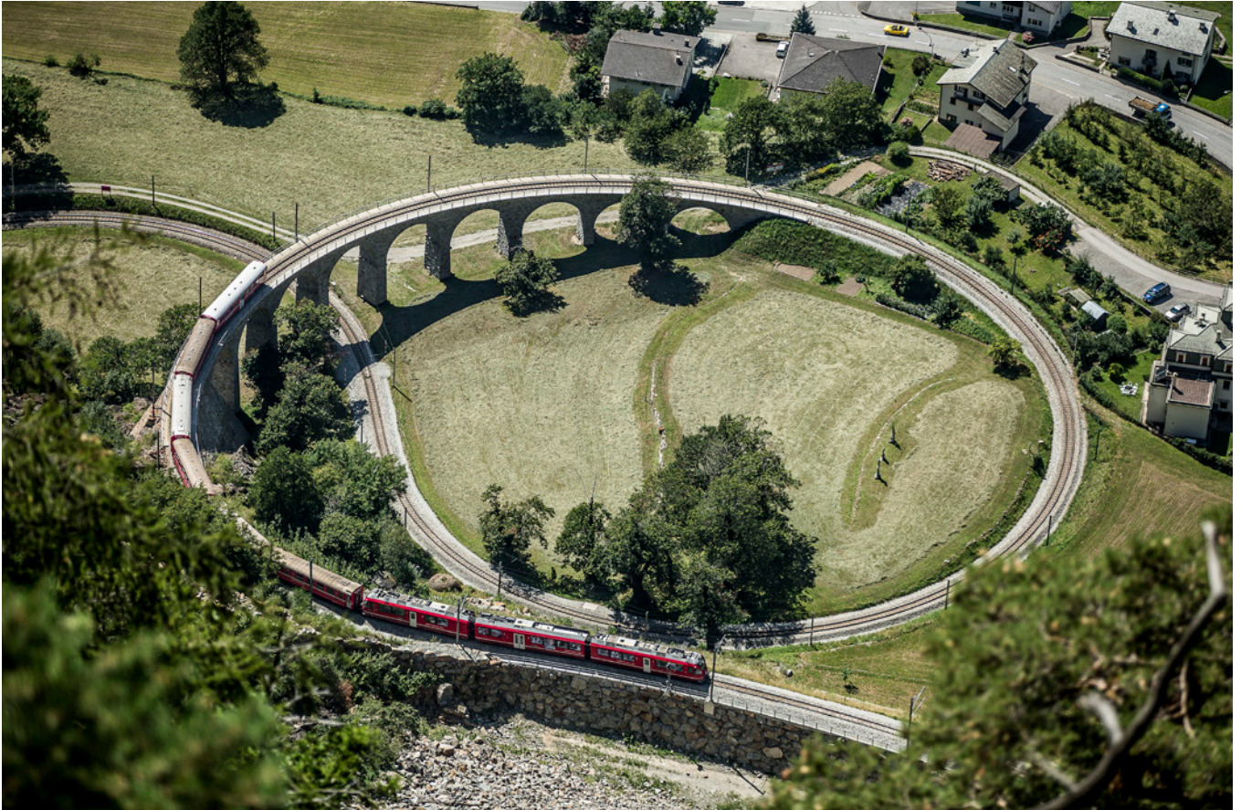
19. Ferrovia retica – viadotto circolare di Brusio
