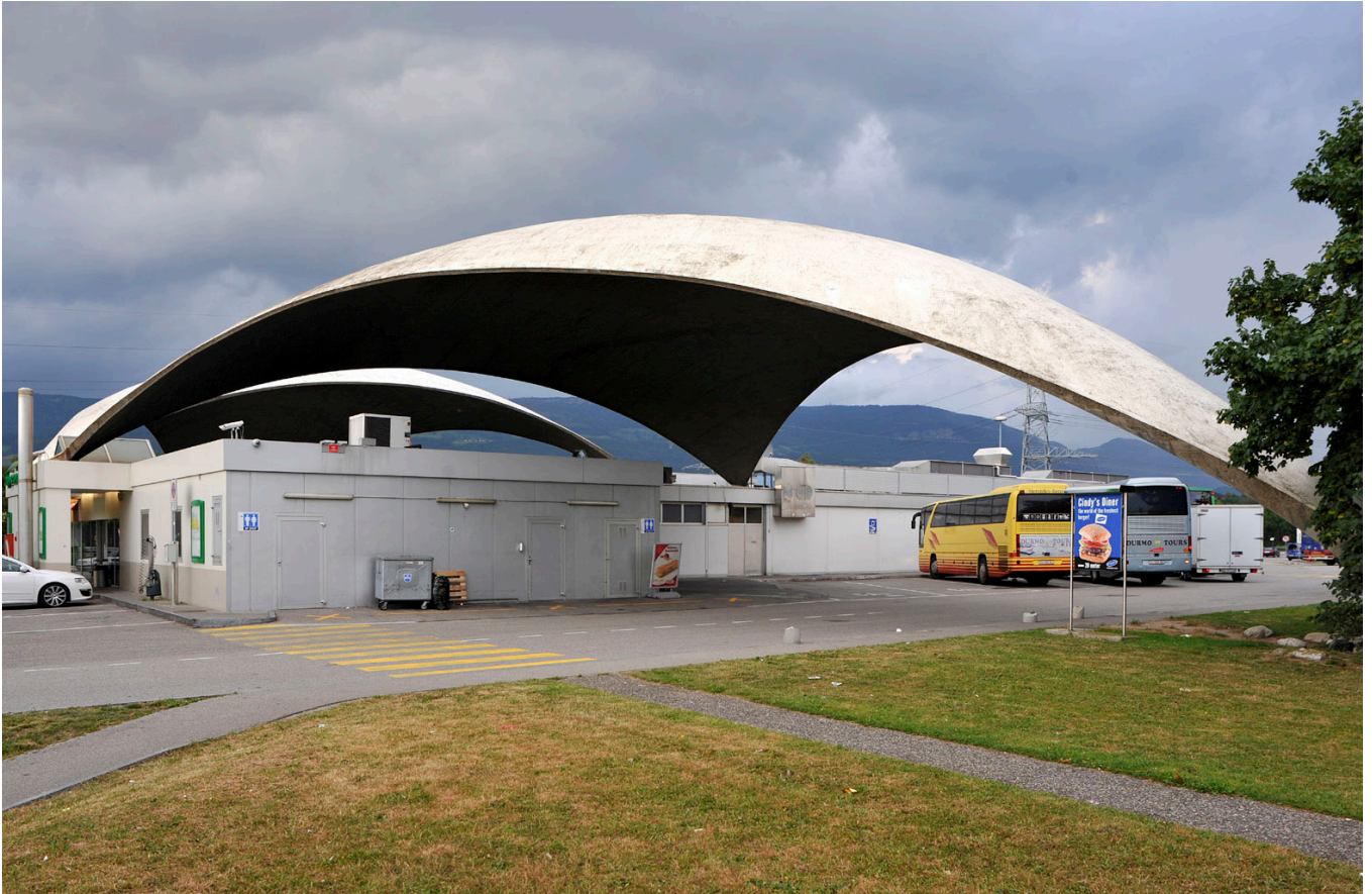
11. Area di servizio autostradale di Deitingen Sud
